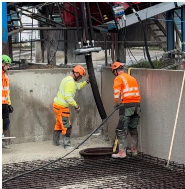
Bild. 5 Gjutare handstyr slangen för att säkra rätt nivå och precision runt brunnen.
